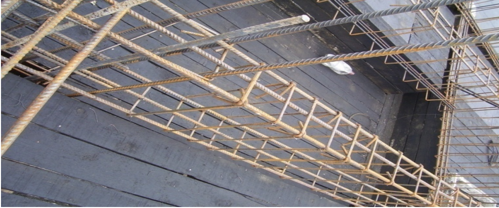
Şekil 2.10. Kirişlerde gövde donatısı gereken kesitlerde gövde donatısının kullanılmaması durumuna bir örnek
