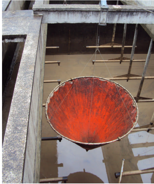
Şekil 21. Çamur toplama konisi
