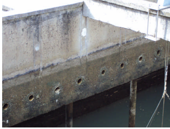
Şekil 23. Su kanallarına giriş orifisleri
