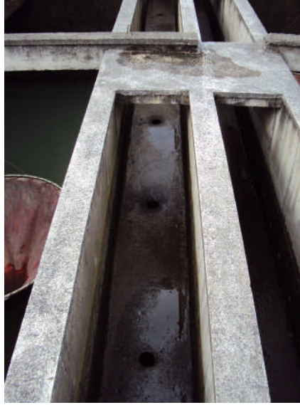
Şekil 19. Durultucu kanallarında threelent girişleri
