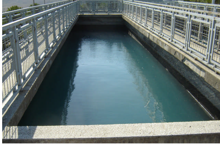
Şekil 8. Dikdörtgen çökeltim havuzu
