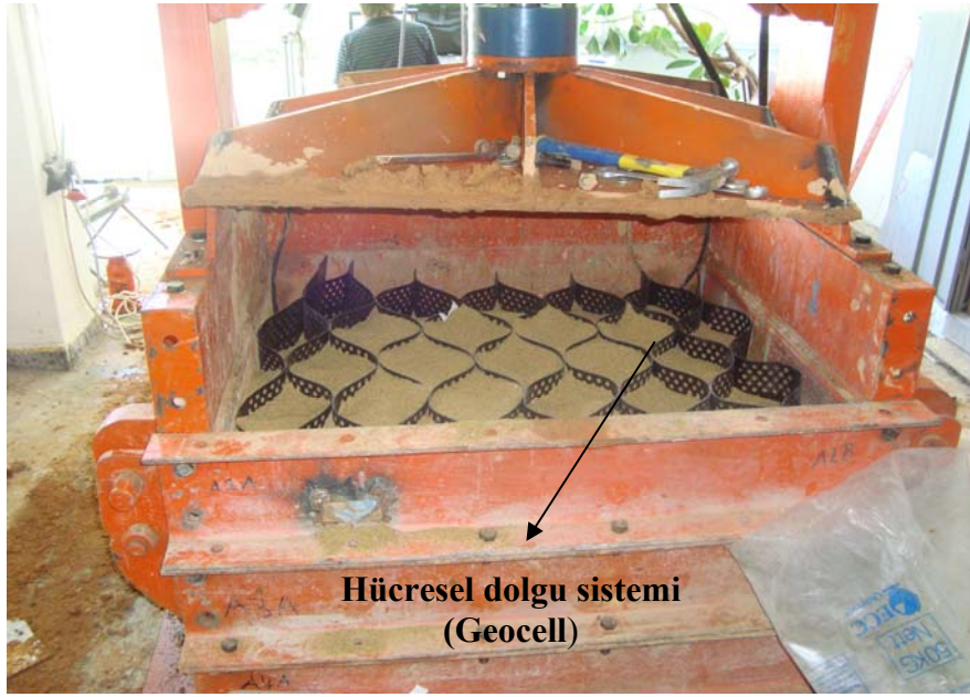
Şekil 2.10. Taban zemini üzerine yerleştirilen geocell ve geocell hücrelerinin içinin kum ile doldurulması
