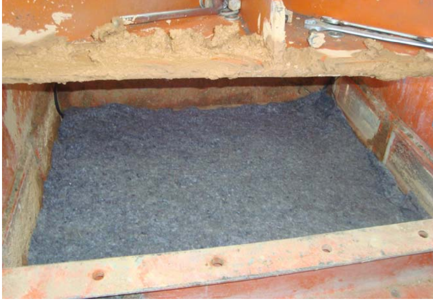
Şekil 2.9. Geocell altına yerleştirilen geotekstil
