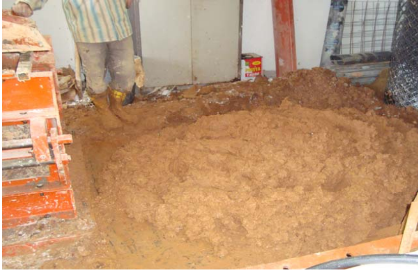
Şekil 2.11. Zeminin % 45 su muhtevasına getirilmesi
