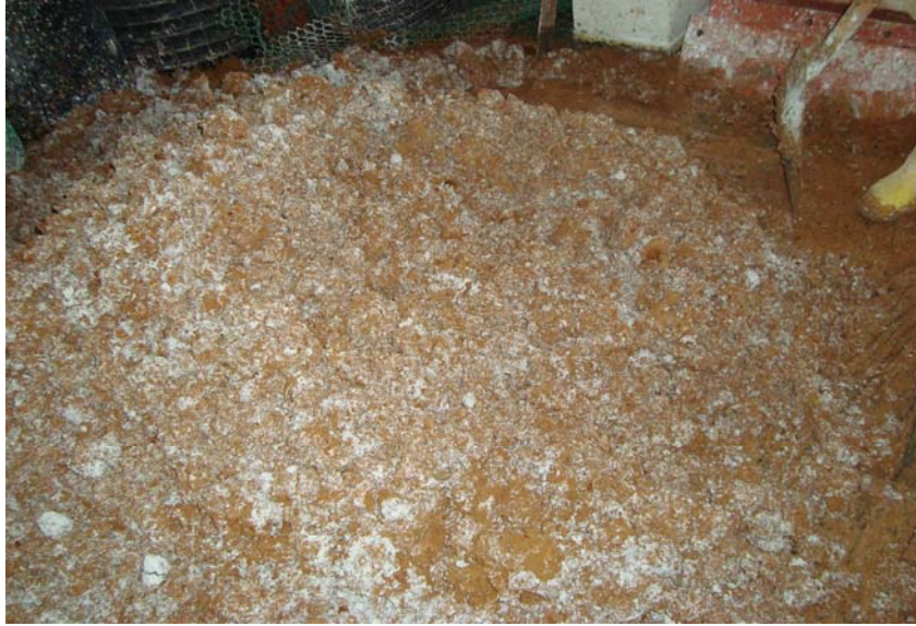
Şekil 2.12. % 45 su muhtevalı killi zeminin kireç ile stabilize edilmesi
