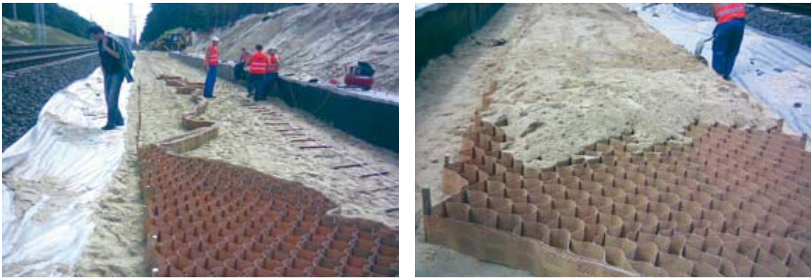
Şekil 1.15 Hücresel dolgu sisteminin arazide uygulanişı [40].
