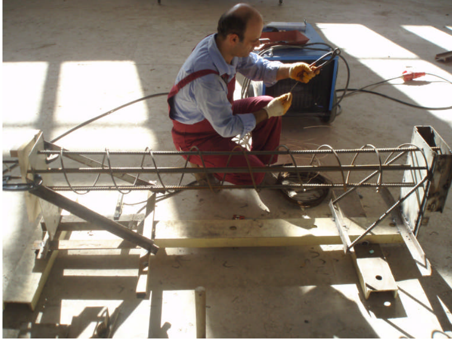
Şekil 2.9. Kolon boyunca donatısı ve sargı donatısının birbirine monte edilmesi
