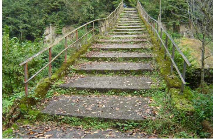
Şekil 1.40. Şenyuva Köprüsü batı kanadı
