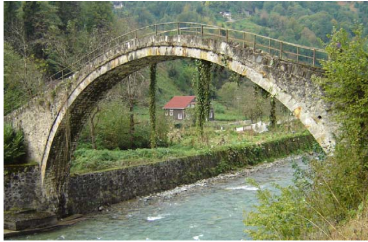
Şekil 1.42. Şenyuva Köprüsü memba görünüşü
