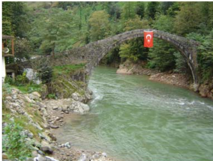
Şekil 1.44. Osmanlı Köprüsü memba görünüşleri
