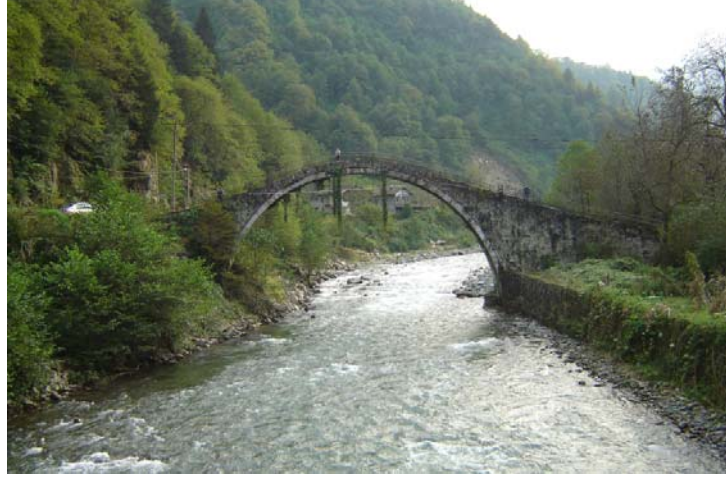
Şekil 1.41. Şenyuva Köprüsü mansap görünüşü
