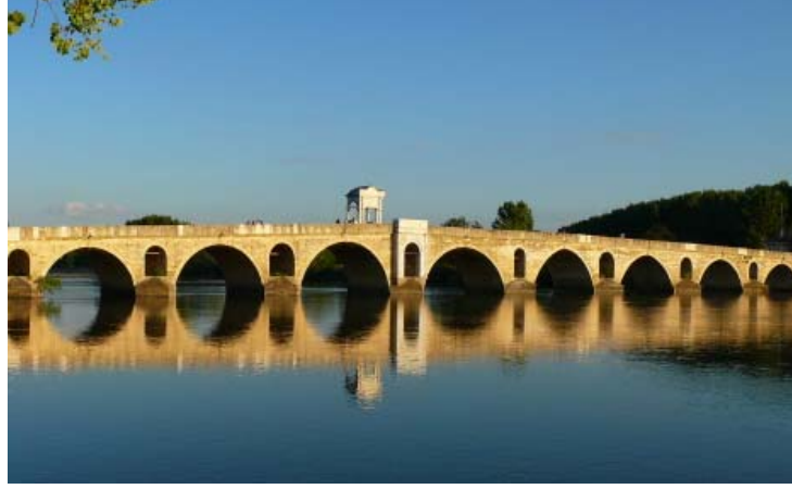
Şekil 1.36. Meriç Köprüsü, Edirne [URL-14].
