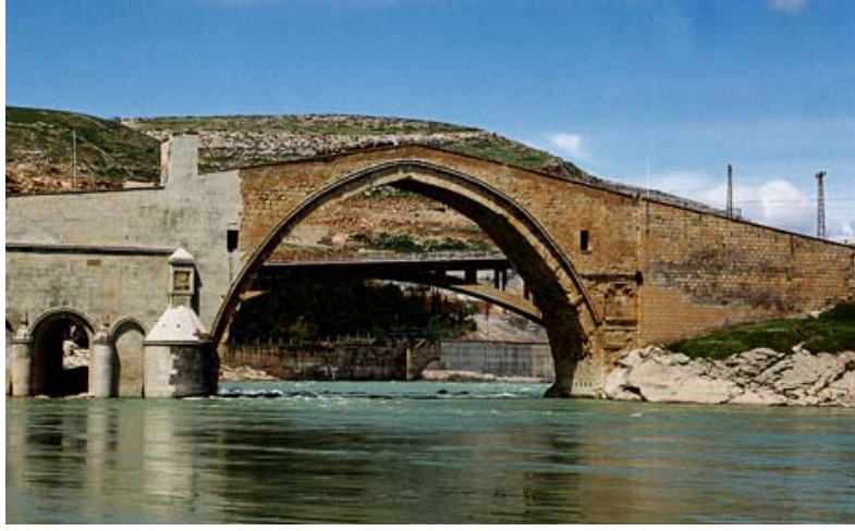
Şekil 1.32. Malabadi Köprüsü, Diyarbakır [URL-11].
