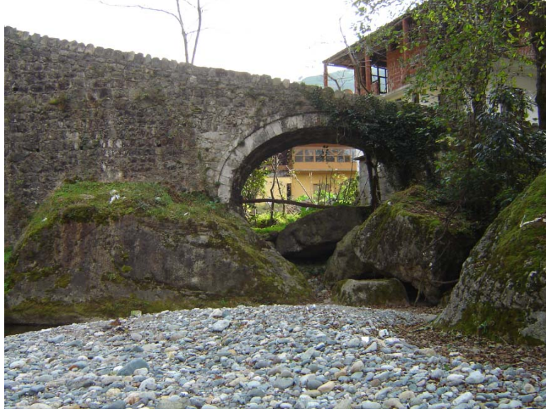
Şekil 1.46. Güneybatı yönündeki boşaltma gözü
