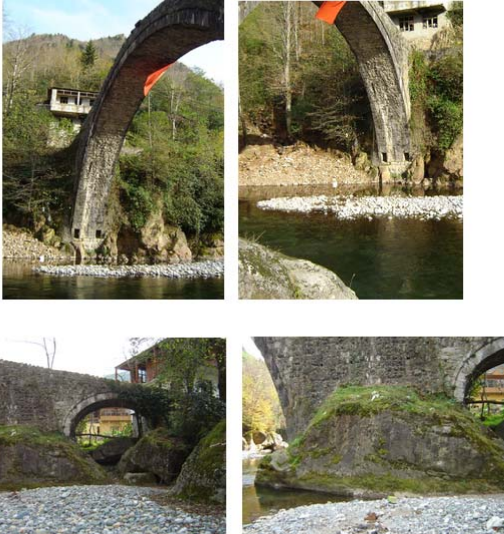
Şekil 2.21. Osmanlı Köprüsü yan duvarlarındaki mesnetleşmeler
