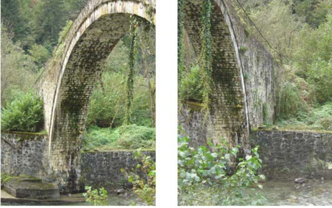
Şekil 2.20. Şenyuva Köprüsü yan duvarlarındaki mesnetleşmeler
