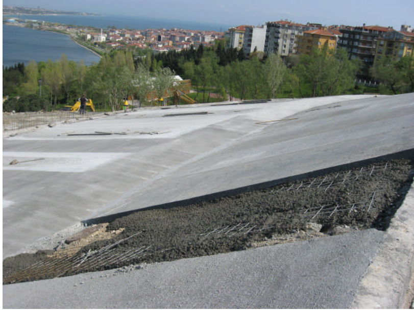
Ek Şekil 14. Yüzey koruma betonu uygulaması
