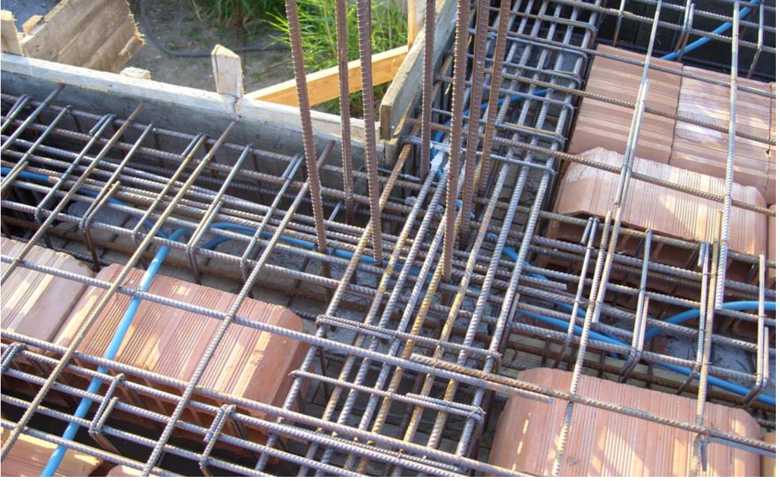
Şekil 2.17. Kuşatılmış kolon–kiriş birleşim bölgelerinde enine donatı ile ilgili verilen şartlara uyulmaması durumu
