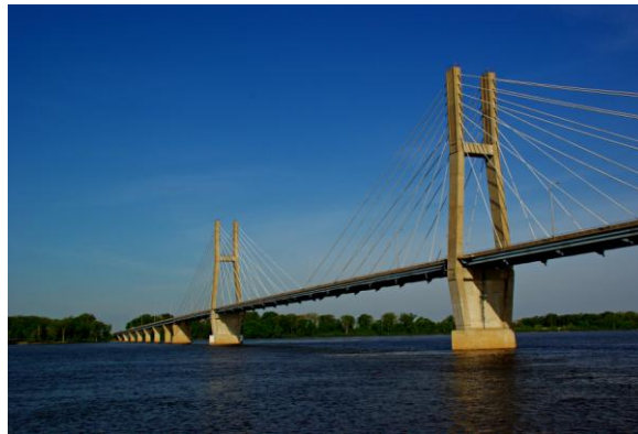
Şekil 3.5. Quincy Bay-view Köprüsü
