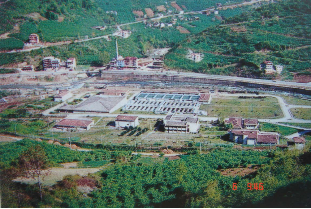
Şekil 2. Trabzon içme suyu arıtma tesisinden bir görünüş (ATASU)
