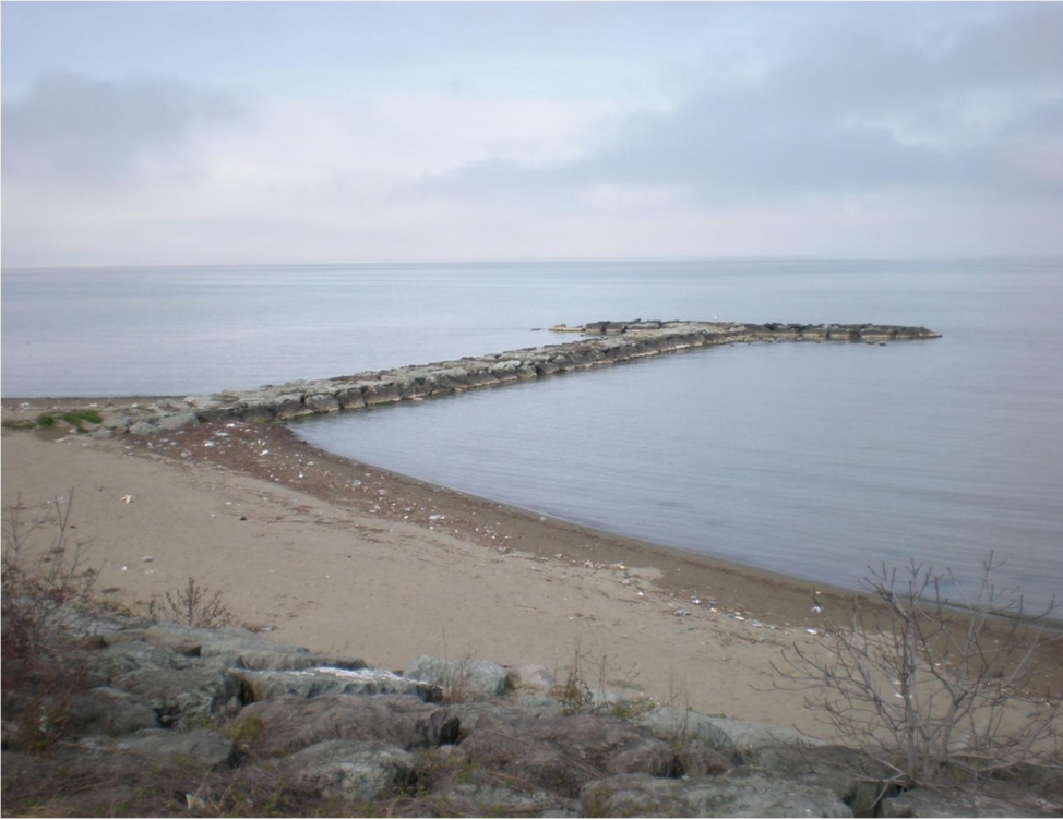
Ek Şekil 6. Sürmene çıkışı T mahmuz görünümü
