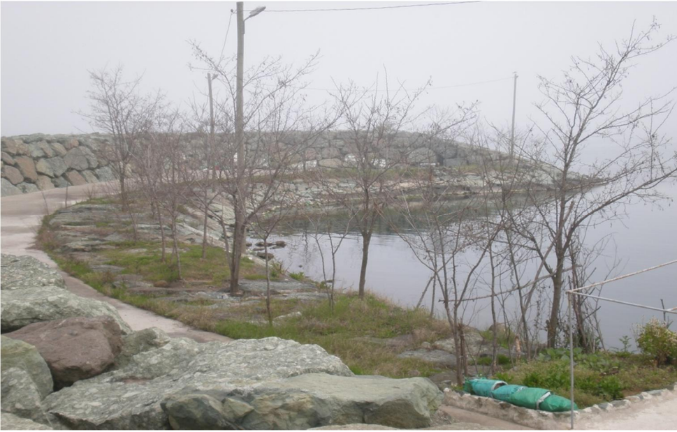
Şekil 3.16. Derepazarı Balıkçı Barınağı
