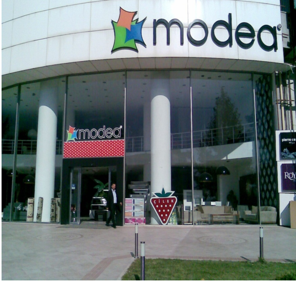
Şekil 2.6 Yumuşak katlı bir betonarme bina
