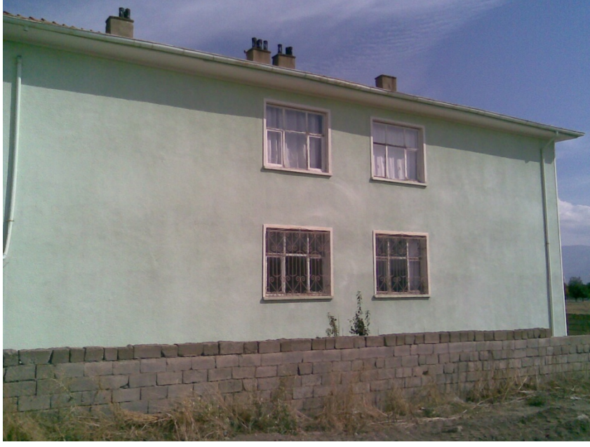
Şekil 2.19 Duvar boşluk oranı az olan yığma bir bina
