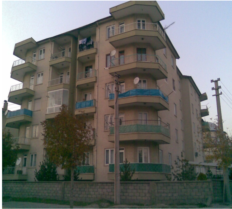
Şekil 2.4 1992 Erzincan depreminde yıkılmamış beş katlı bir bina
