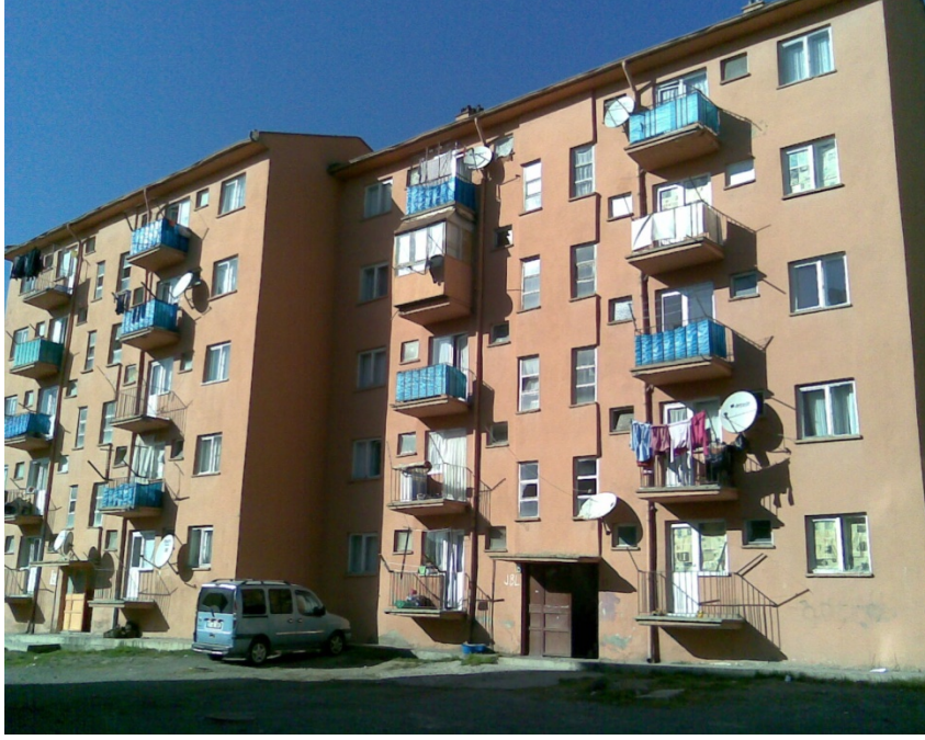
Şekil 2.3 1992 Erzincan depreminde yıkılmamış bitişik nizam beş katlı bina
