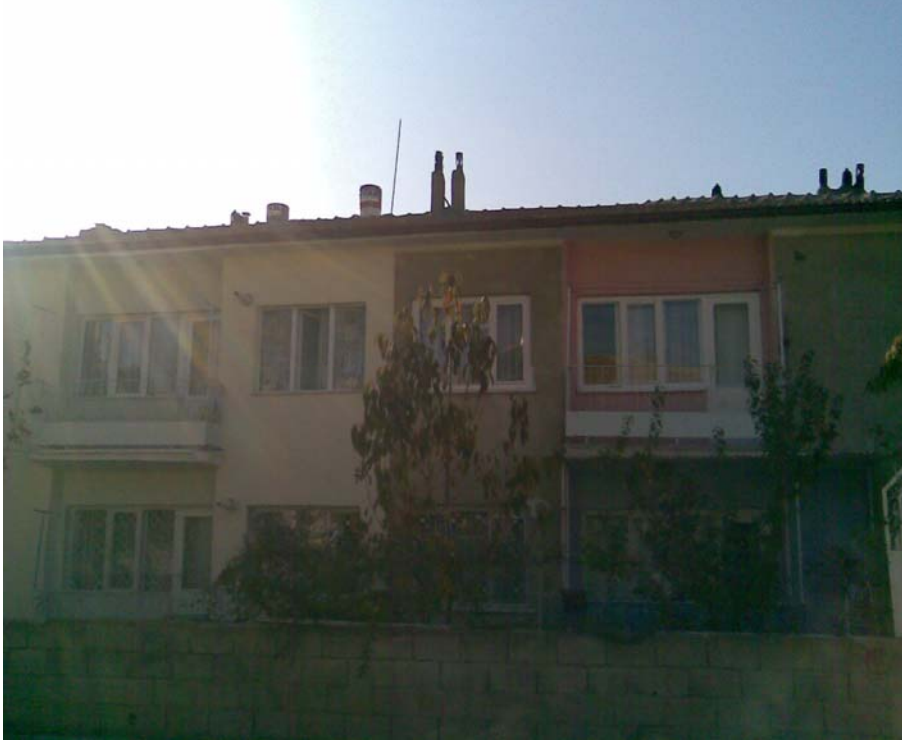
Şekil 2.18 Duvar boşluk oranı fazla olan yığma bina
