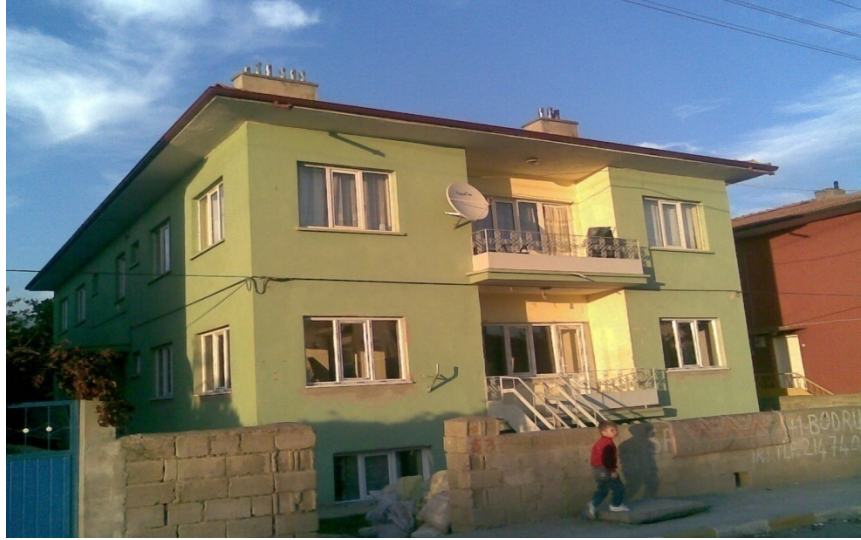
Şekil 2.21 Duvar boşluk düzeni, düzenli bir yığma bina
