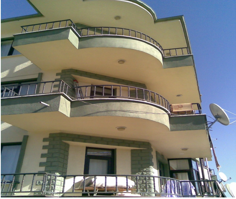
Şekil 2.8. Geniş, ağır parapetli bir balkona sahip bina
