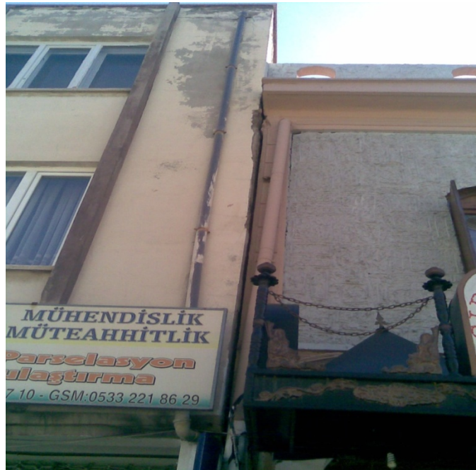
Şekil 2.14. Birbirine bitişik ve çarpışma etkisi oluşturan yapılar
