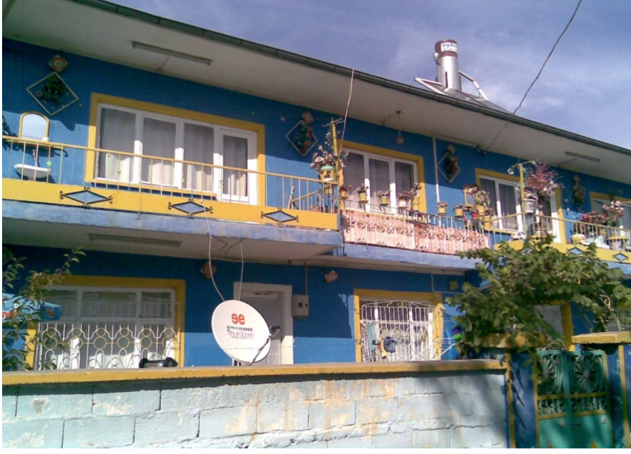
Şekil 2.15 Yığma yapılan ve dış görünüşü kaliteli yapı
