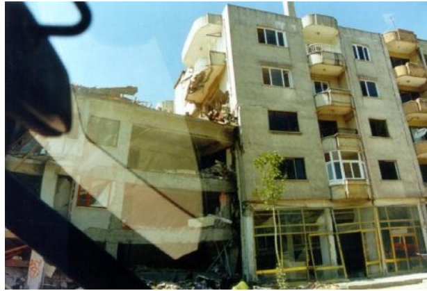
Şekil 1.7. 1999 Kocaeli depremi sonrası farklı yapı yüksekliğine sahip binalardaki hasarlar (URL – 2, 2010)
