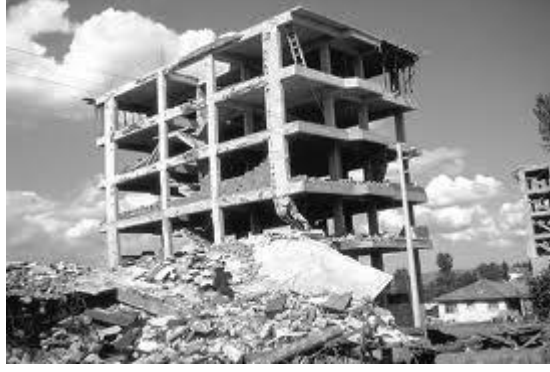
Şekil 1.9. 1999 Kocaeli depremi sırasında işlevini yitirmiş kolon ve yıkılmış komşu bina (URL – 3, 2010)
