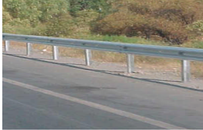
Şekil 18. Basit otokorkuluk (2,00 m dikme aralıklı) (URL-5, 2010)
