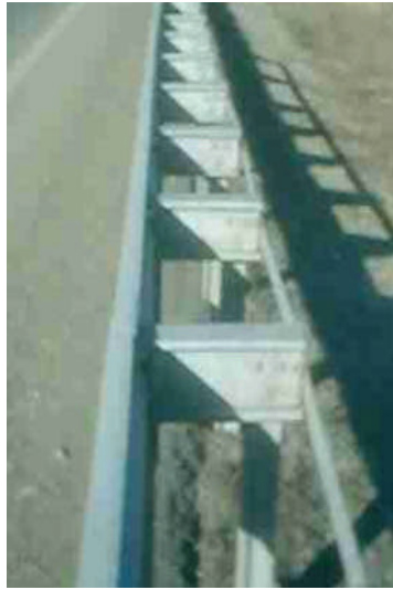
Şekil 20. Basit mesafeli otokorkuluk (2,00 m.dikme aralıklı) (URL-8, 2010)
