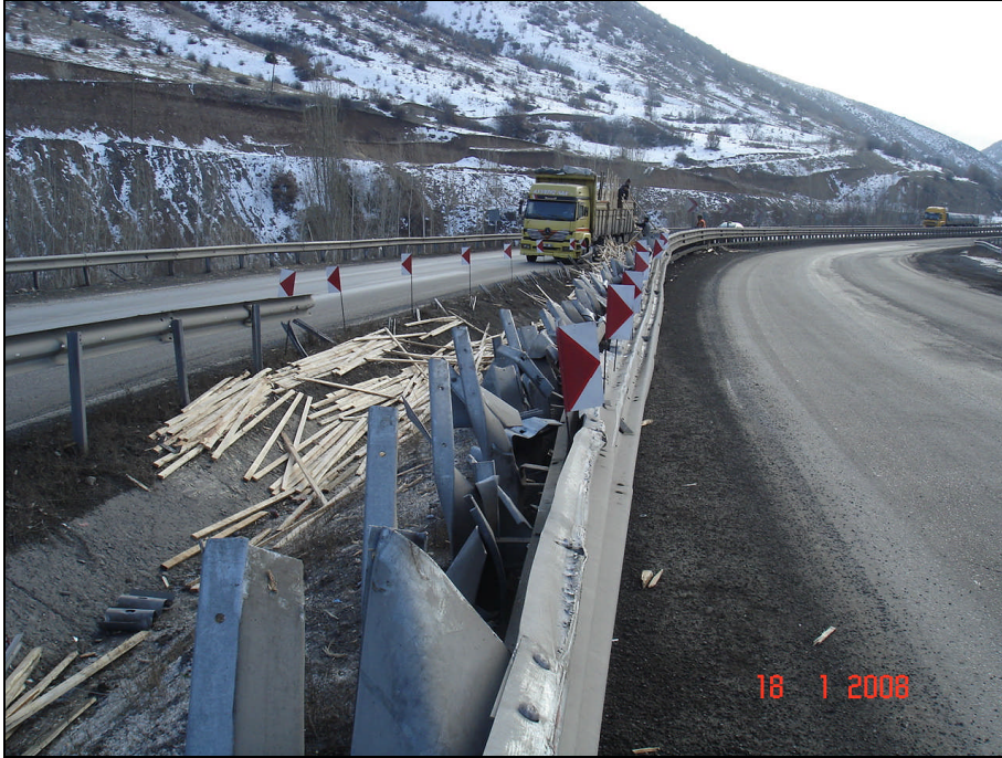
Şekil 97. Ağır hizmet otokorkuluğunun Azaphane virajı için işlevsel yeterliliği (Azaphane, 2008)
