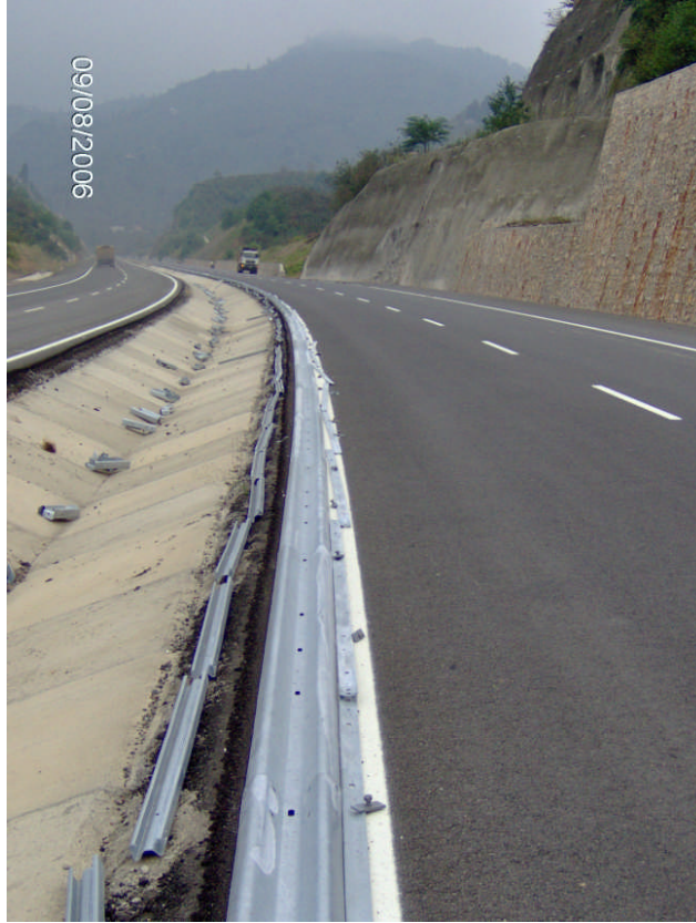
Şekil 5. Karayoluna paralel açılmış kanallar
