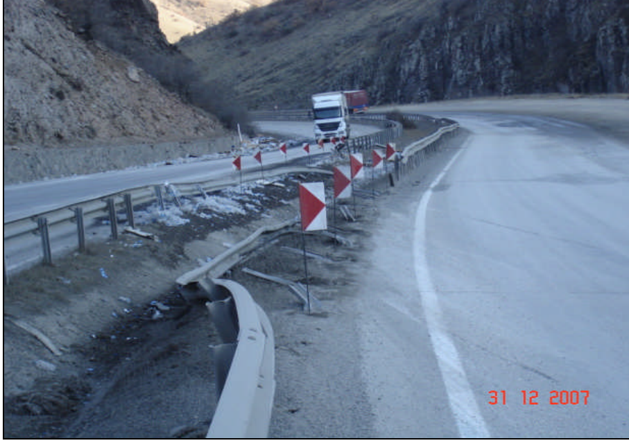
Şekil 96. Basit otokorkulukların Azaphane virajı için işlevsel yetersizlikleri (Azaphane, 2007)
