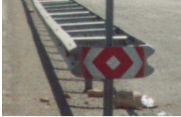
Şekil 23. Çift taraflı mesafeli otokorkuluk (2,00 m dikme aralıklı)
