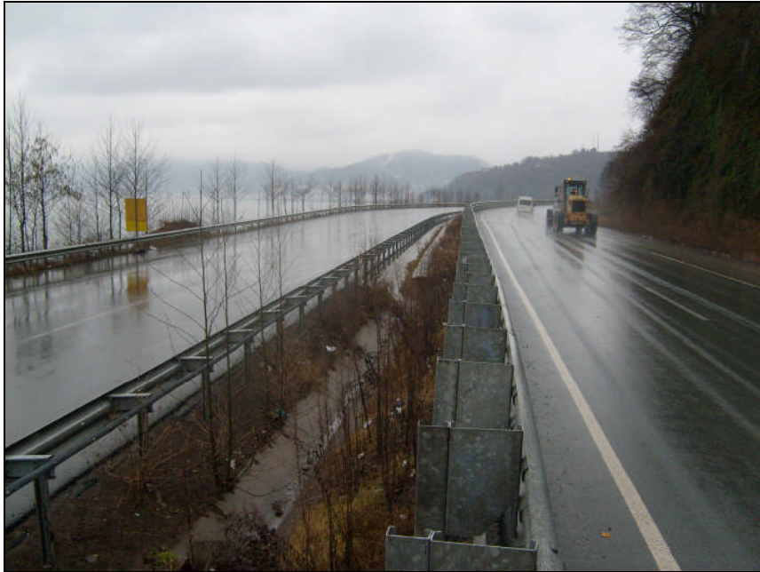
Şekil 91. Yanal deformasyonu 0.6 - 3.5 m olan çelik otokorkuluklar (Hopa, 2007)
