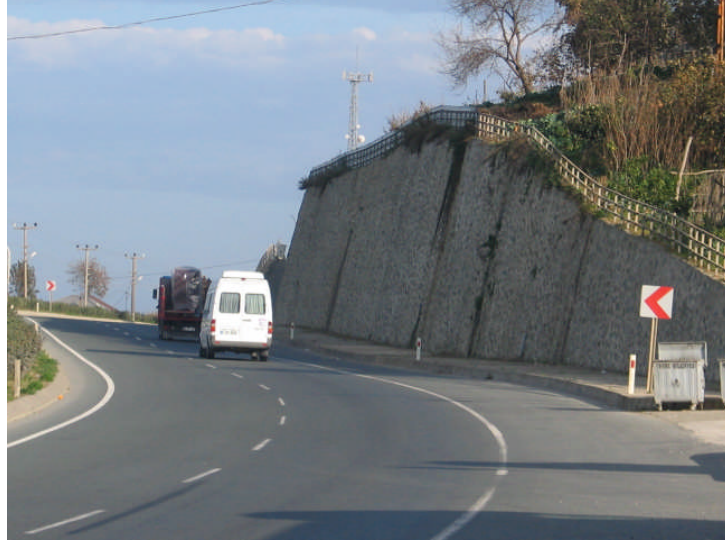
Şekil 11. İstinat duvarları (Yomra/Trabzon çıkış kavşağı yanı, 2010)
