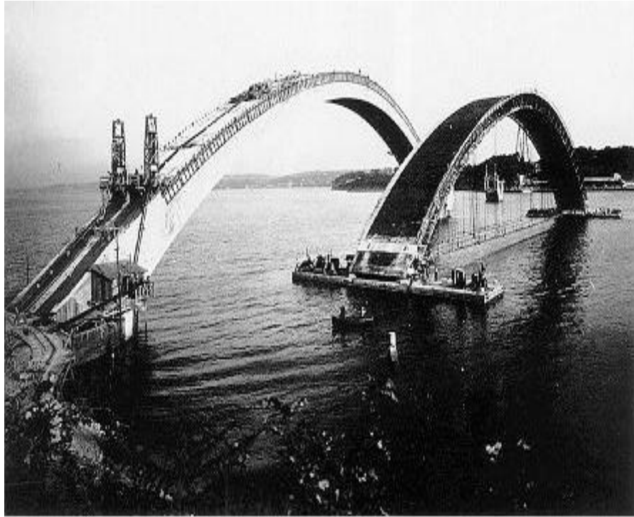
Şekil 1.1. Yapım aşamasındaki Plougastel Köprüsü (Brown, 1993).
