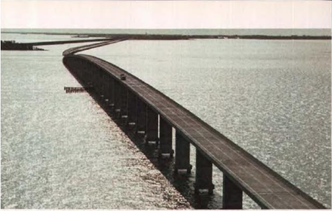
Şekil 1.7. Seven Mile Köprüsü
