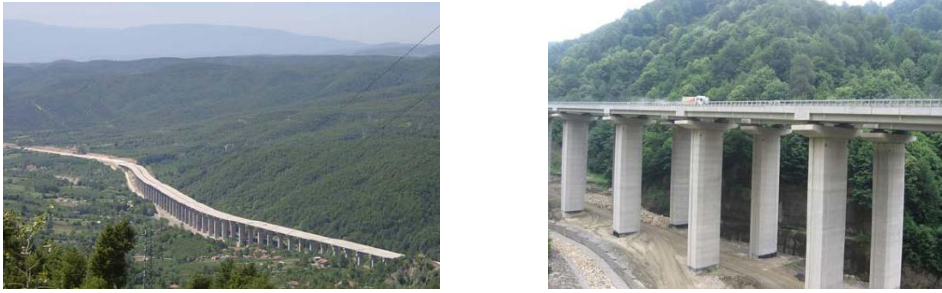
Şekil 1.25. Bolu Viyadükü'nden görünüm
