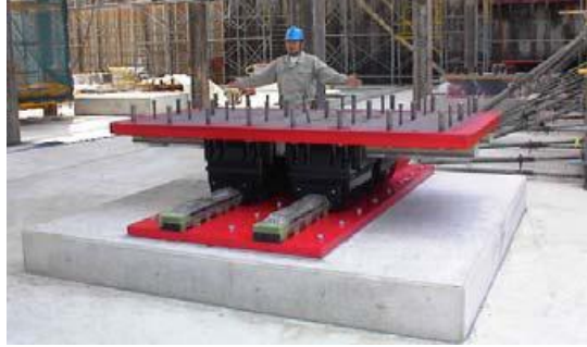
Şekil 1.9. Çapraz doğrusal hareket sisteminin görünüşü
