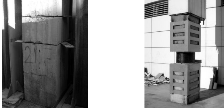
Şekil 1.24. Antalya Havaalanı'ndaki sismik izolasyon uygulaması
