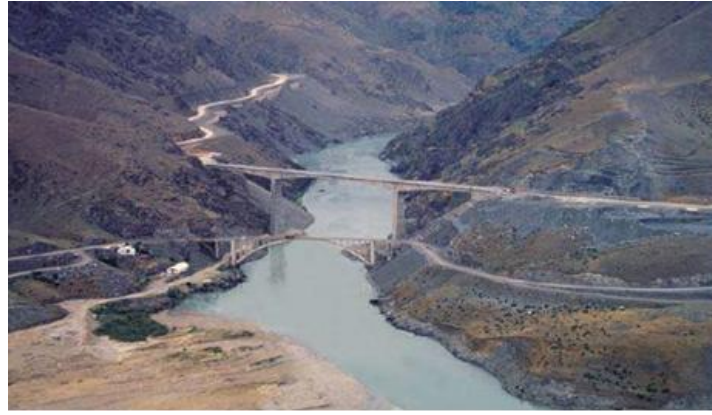
Şekil 2.1. Kömürhan Köprüsü'ne ait bazı fotoğraflar
